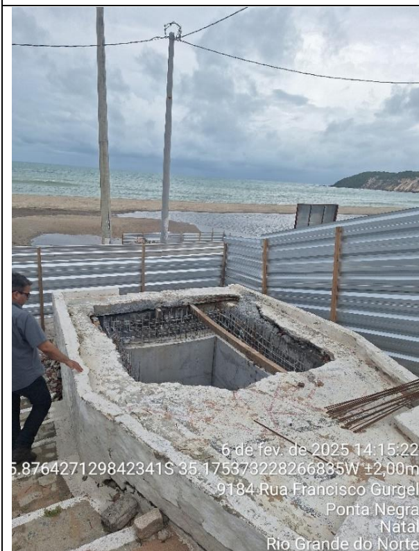
Figura 30 - Caixa dissipadora a montante do D09
