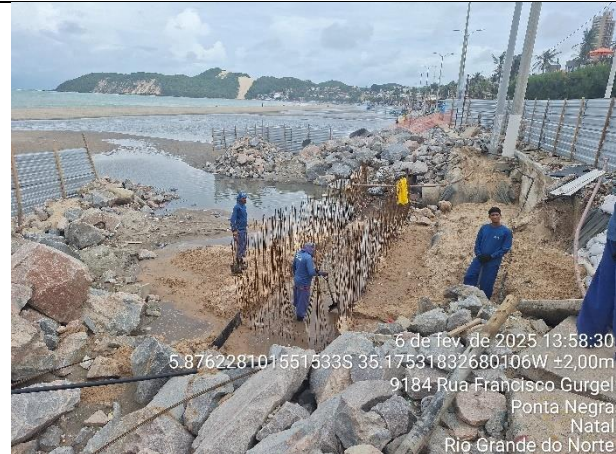
Figura 29 - Execução da armação e fundo do dissipador 09.
