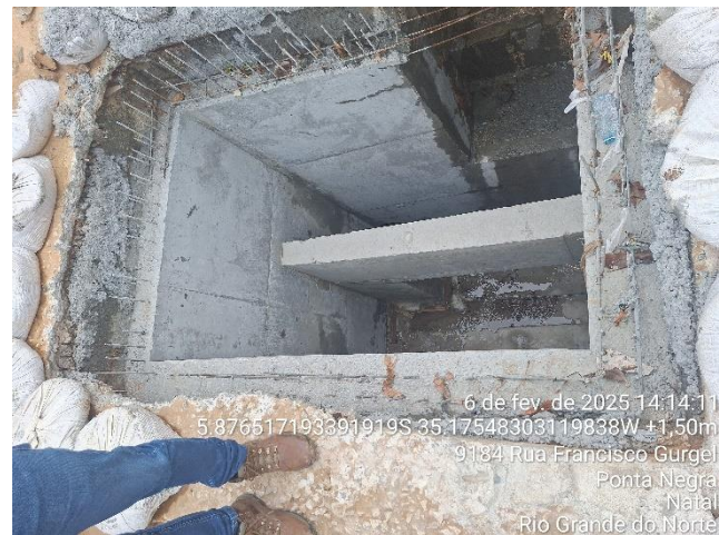
Figura 31 - Detalhe de outra caixa dissipadora a montante do dissipador D09.
