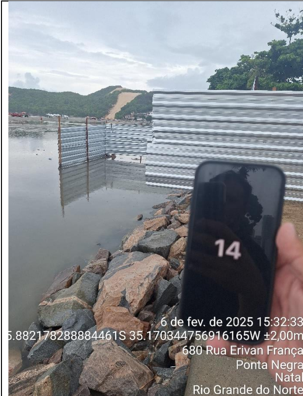
Figura 36 – Dissipador D14 e lagoa.
