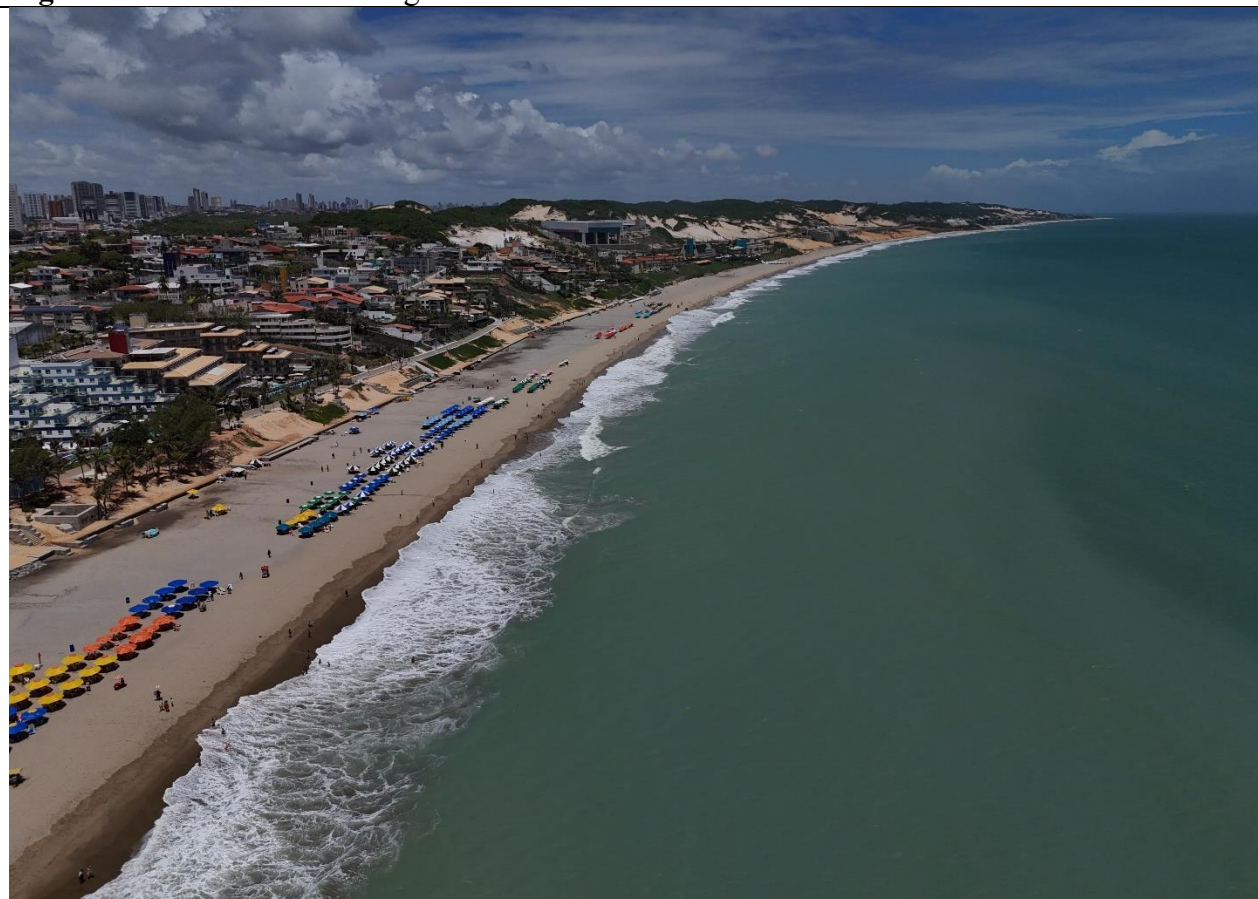
Figura 20 – Vista de sul para norte do aterro hidráulico.
